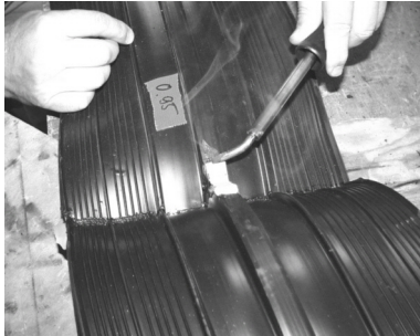
Schweißungsarbeit im Atelier und auf der Baustelle.
