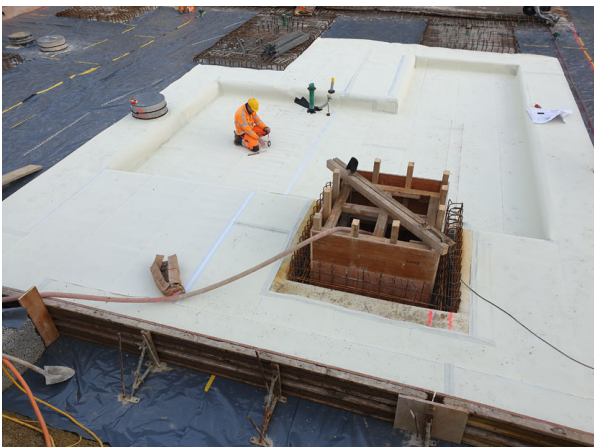
Vollflächige Abdichtungsfolie Ecotight Plus Feuille d'étanchéité pleine surface Ecotight Plus Stuoia impermeabile area piena Ecotight Plus
