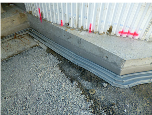
Dilatationsband Alt-Neubau Anschluss DFT 240/3 EI Bande de dilatation ancien-nouveau DFT 240/3 EI Nastro di dilatazione vecchio-nuovo DFT 240/3 EI
