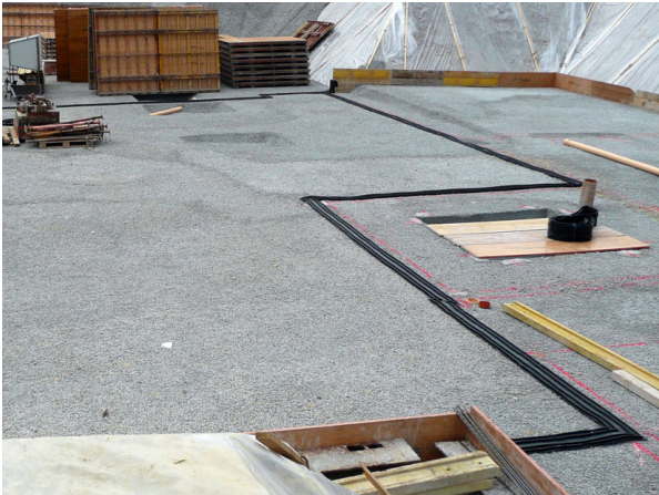
Arbeitsfugenband AA240 Bande d'étanchéité pour joints de reprise AA240 Nastro per giunti di lavoro AA240
